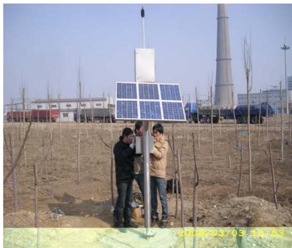
图 7.2 技术人员正在安装环境噪声自动监测系统
